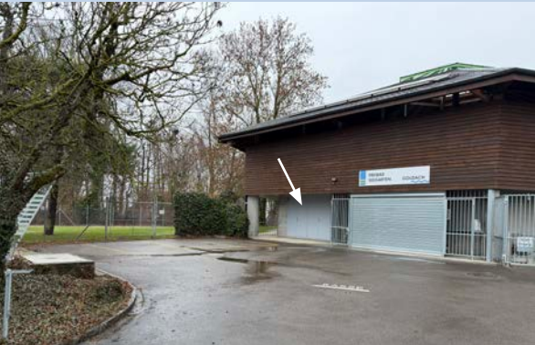
Standort des Pumpwerks Freibad Seegarten
