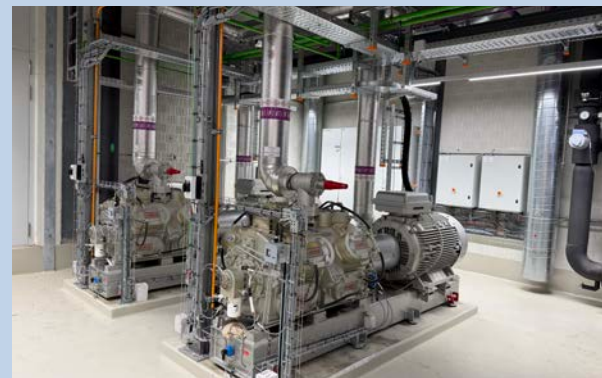
Wettstein-Wärmepumpe mit Ammoniak als Kältemittel
