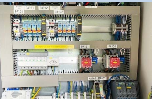
Innensicht auf die Steuereinheit nach ATEX-Norm
