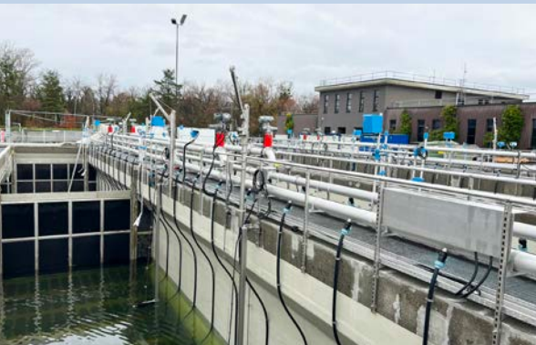
Sanierter Biologieblock 10 mit Betriebswasserfüllung
