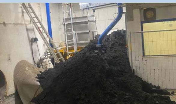
Schlammaustritt aufgrund Leitungsdefekt an der Putzmeisterpumpe
