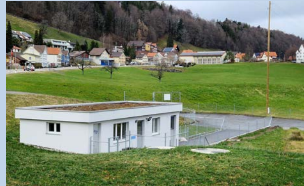
PW Grub nach der Sanierung
