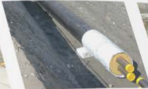
Detail der zwei Stahlrohr-Wärmeleitungen isoliert mit PUR-Schaumstoff und umhüllt mit einem Kunststoffmantelrohr
