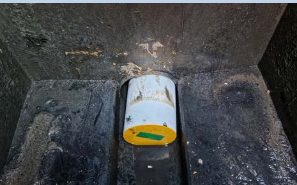
Einsetzen des Molches in die Leitung
