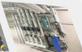
Fernwärme-Unterstation in einer privaten Liegenschaft
