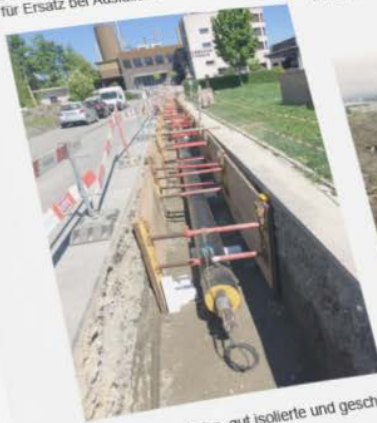
Detail der zwei Stahlrohr-Wärmeleitungen isoliert mit PUR-Schaumstoff und umhüllt mit einem Kunststoffmantelrohr
