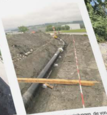
Detail der zwei Stahlrohr-Wärmeleitungen isoliert mit PUR-Schaumstoff und umhüllt mit einem Kunststoffmantelrohr
