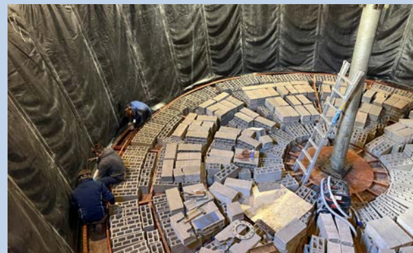
Membranersatz am Gasometer
