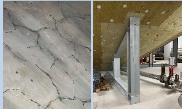
Statische Unterfangung an den Trichtern FA10 und 20
