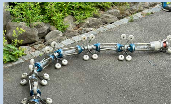
Lichterkette zum Aushärten eines Schlauchliners
