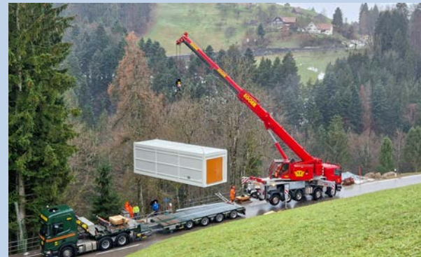
Versetzen des Pumpwerkes Habset
