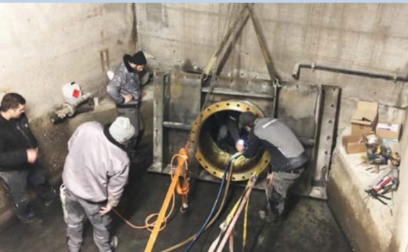
Verankerung/Montage des Übergangsstücks am Zulaufschutz
