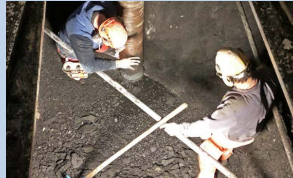
FA30: Absaugaktion der entfernten Foamglas-Isolation
