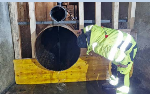
Inbetriebnahme des grossen Zulaufrohrs und des kleinen Rohrs für die internen Rückläufe
