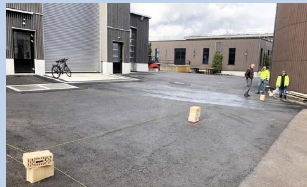
Belagseinbau: Einpassung in die Umgebung
