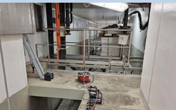
Sanierter Zulaufkanal; Lieferverzögerungen bei Elektrobauteilen
