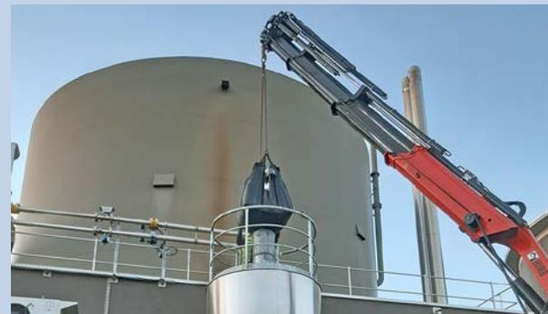
Installation einer Klärgasreinigung (inkl. Kondensationsstufe)
