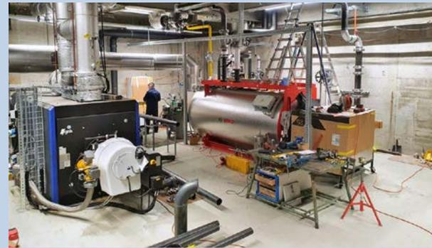
Installation eines Heizkessels zur Spitzenlastdeckung
