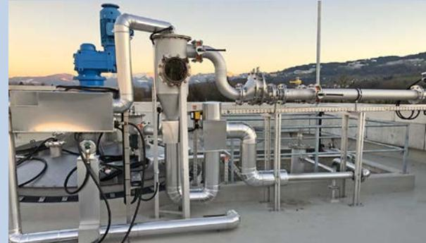
Gasfassung inkl. Schaumfalle auf einem der sanierten SM Behälter
