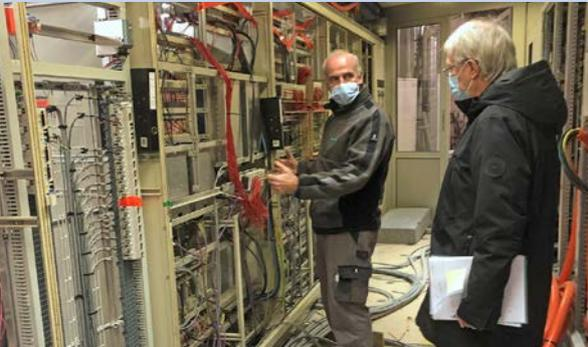
Umbau Niederspannungs-Hauptverteilung NSHV in der SM-Anlage (unter laufendem Betrieb)
