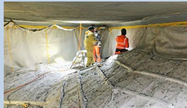
Beschichtungsarbeiten des Düngerbehälters (240 m<sup>3</sup>)
