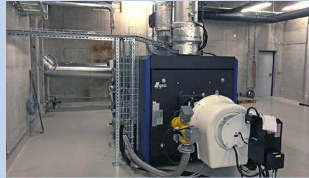
Gasbrenner mit Kessel (Notfackelfunktion)
