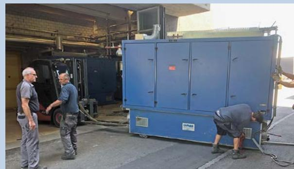
Ausgediente Blockheizkraftwerke (BHKW)
