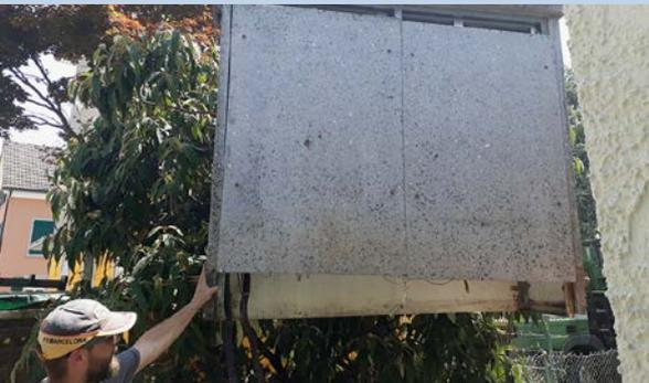
Demontage des Schaltschranks mit Kraneinsatz
