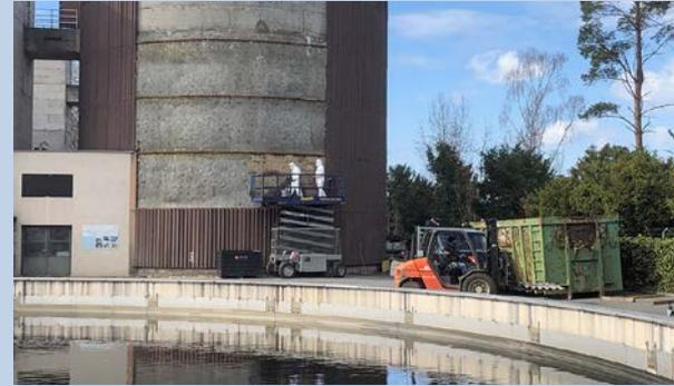
Rückbau der asbesthaltigen Fassade
