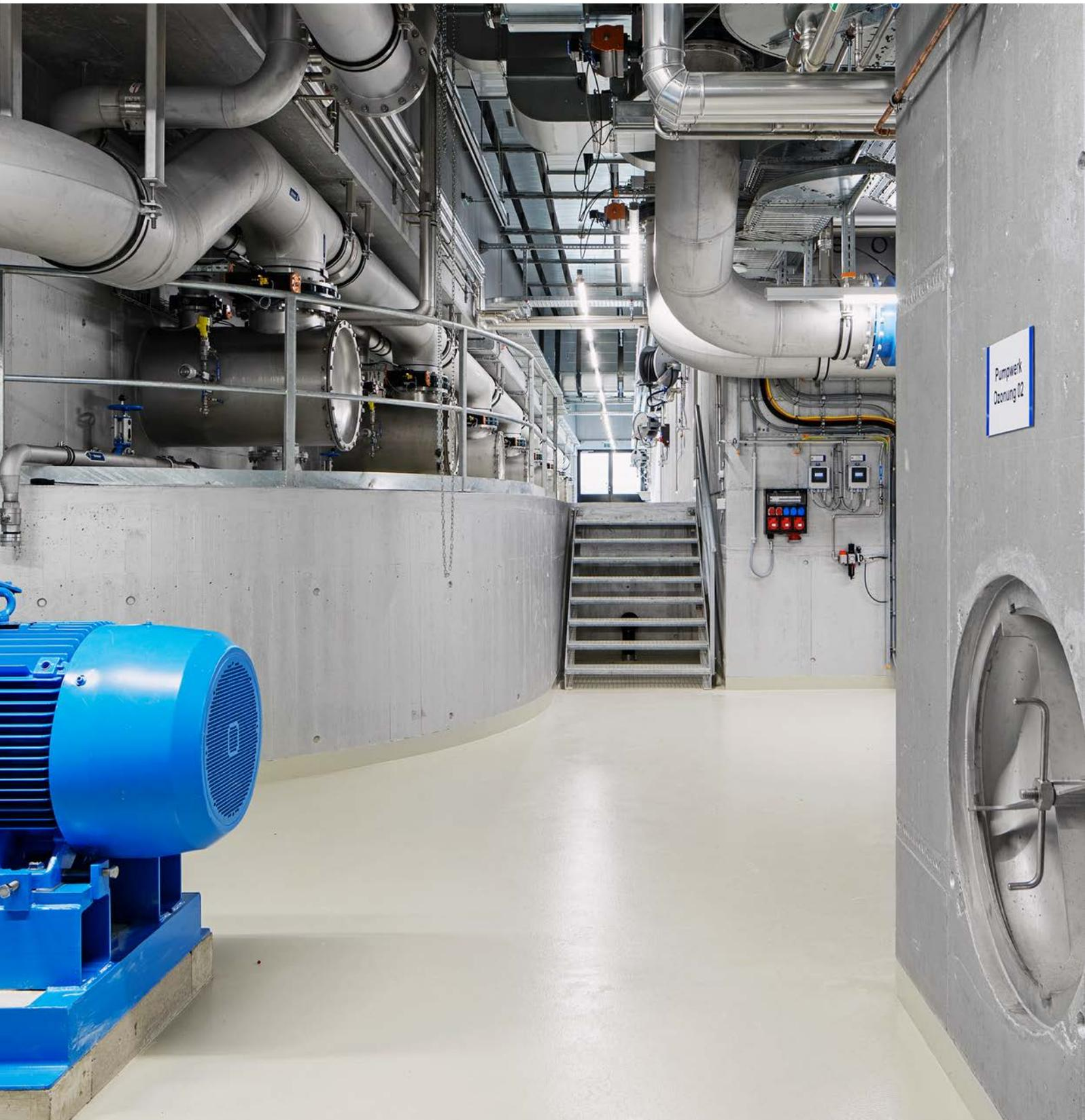
Innenraum Untergeschoss mit Blick auf Pumpensumpf (vorne rechts), Ozonreaktor (hinten rechts) und Filterzellen GAK (hinten links)
