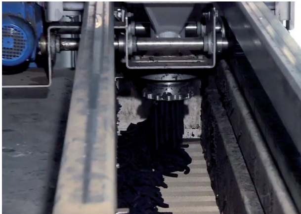
Auftrag des pelletierten Schlammes auf die Trocknungsbänder
