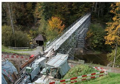
Installation für Bohrung vom Dükertiefpunkt in Richtung Speicher
