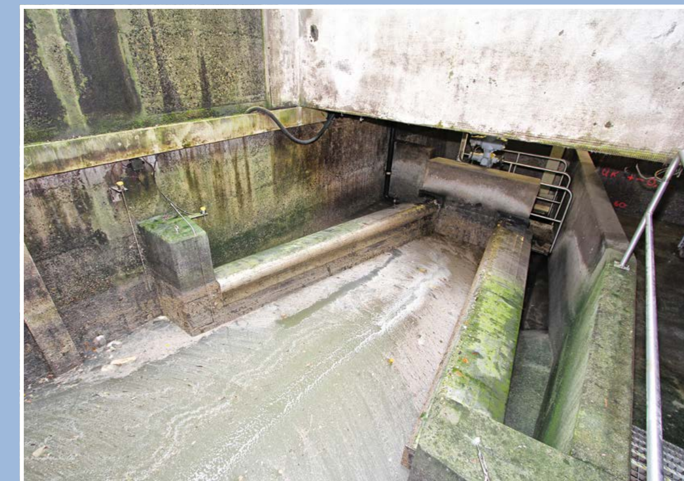
Zulaufstollen zwischen Rorschach und Thal mit Stollenwehr
