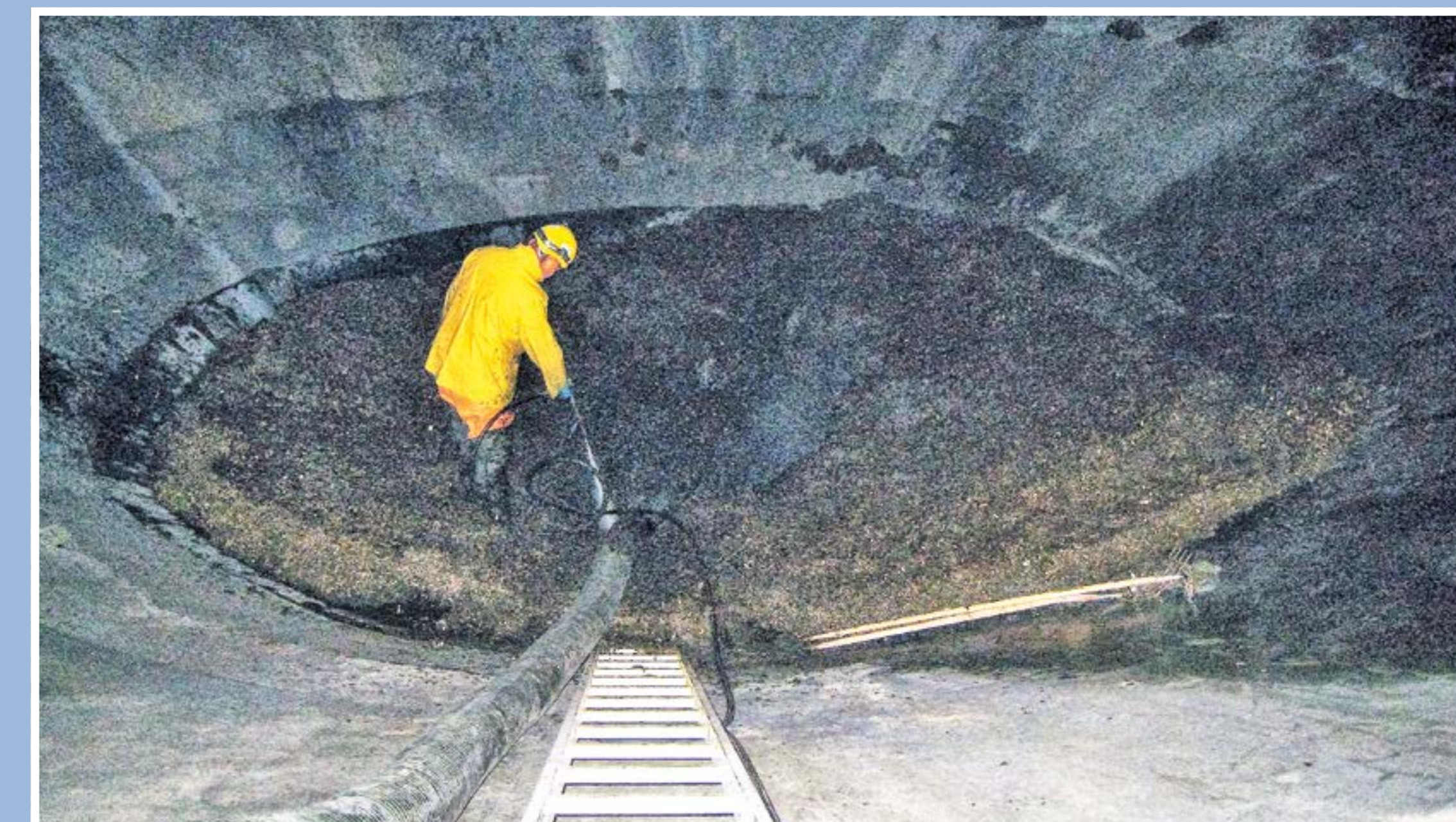
Faulraumkonus während Unterhaltsarbeiten
