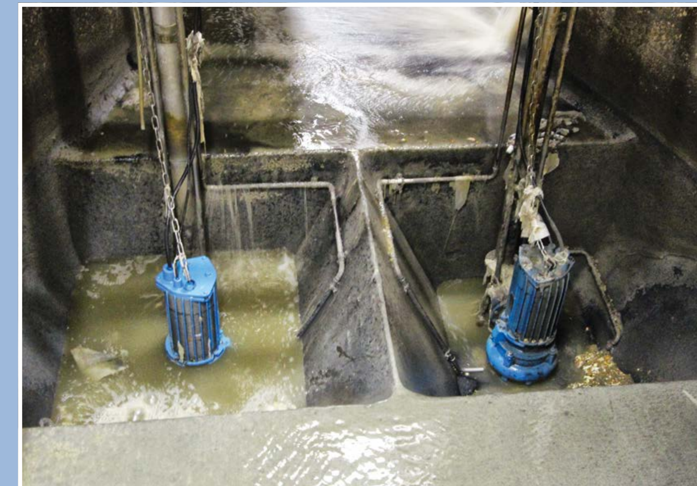
Zulaufkanal mit Kiesfang
