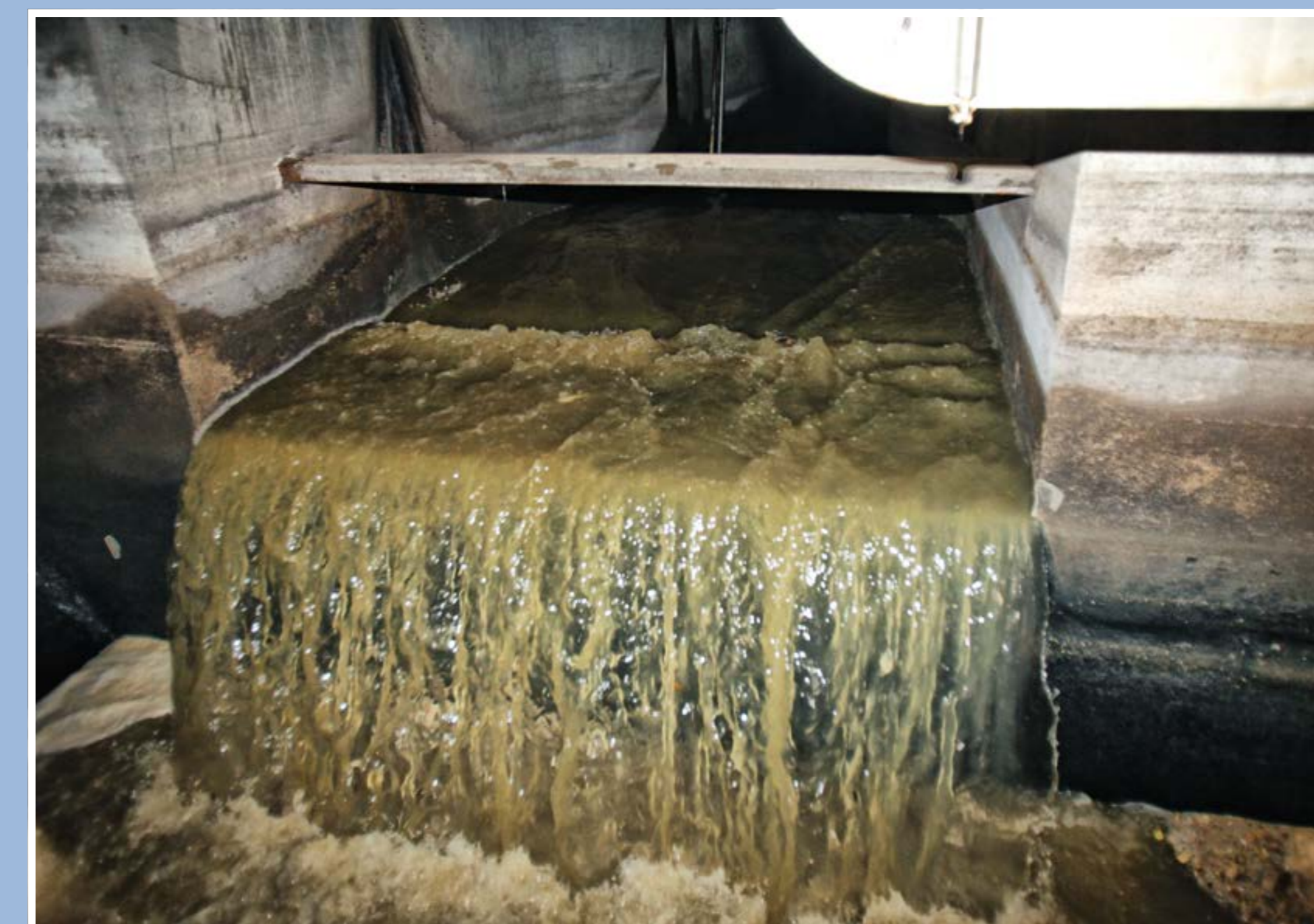
Zulaufkanal mit Überfallkante
