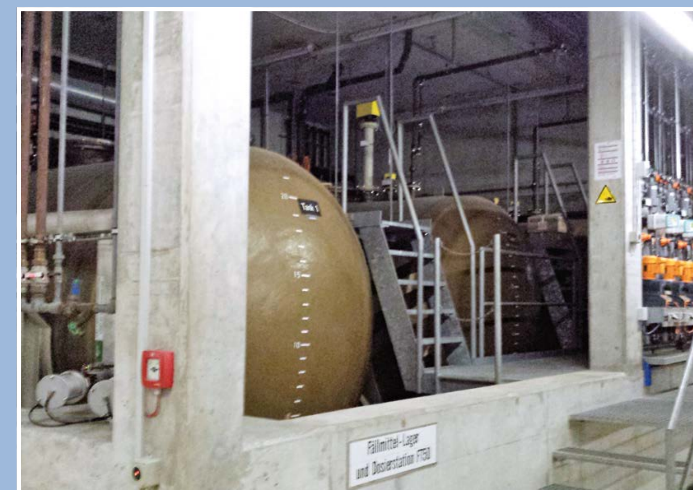
Fällmittellagerung, Dosierstation
