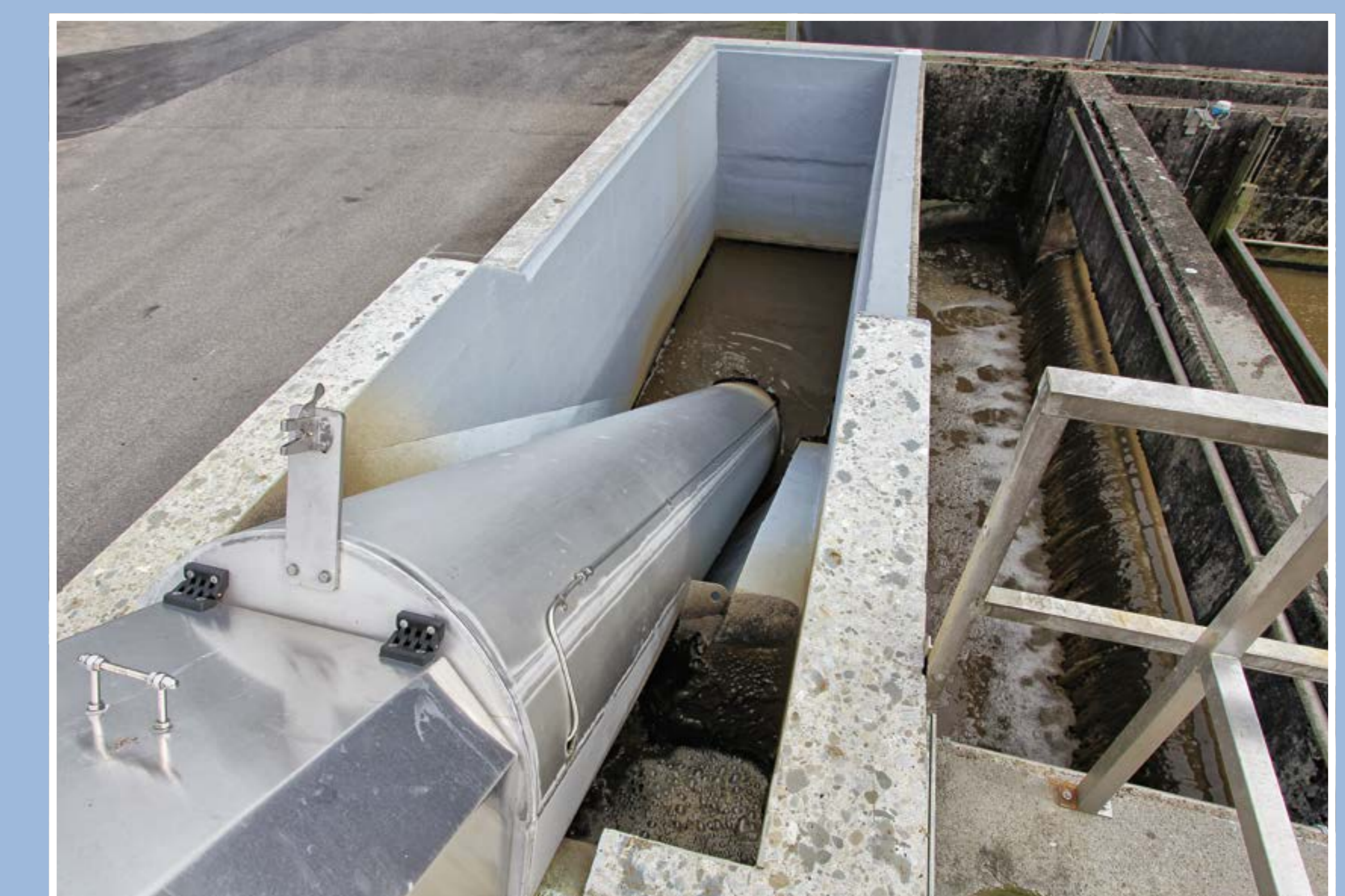
Rücklaufschlammpumpe
