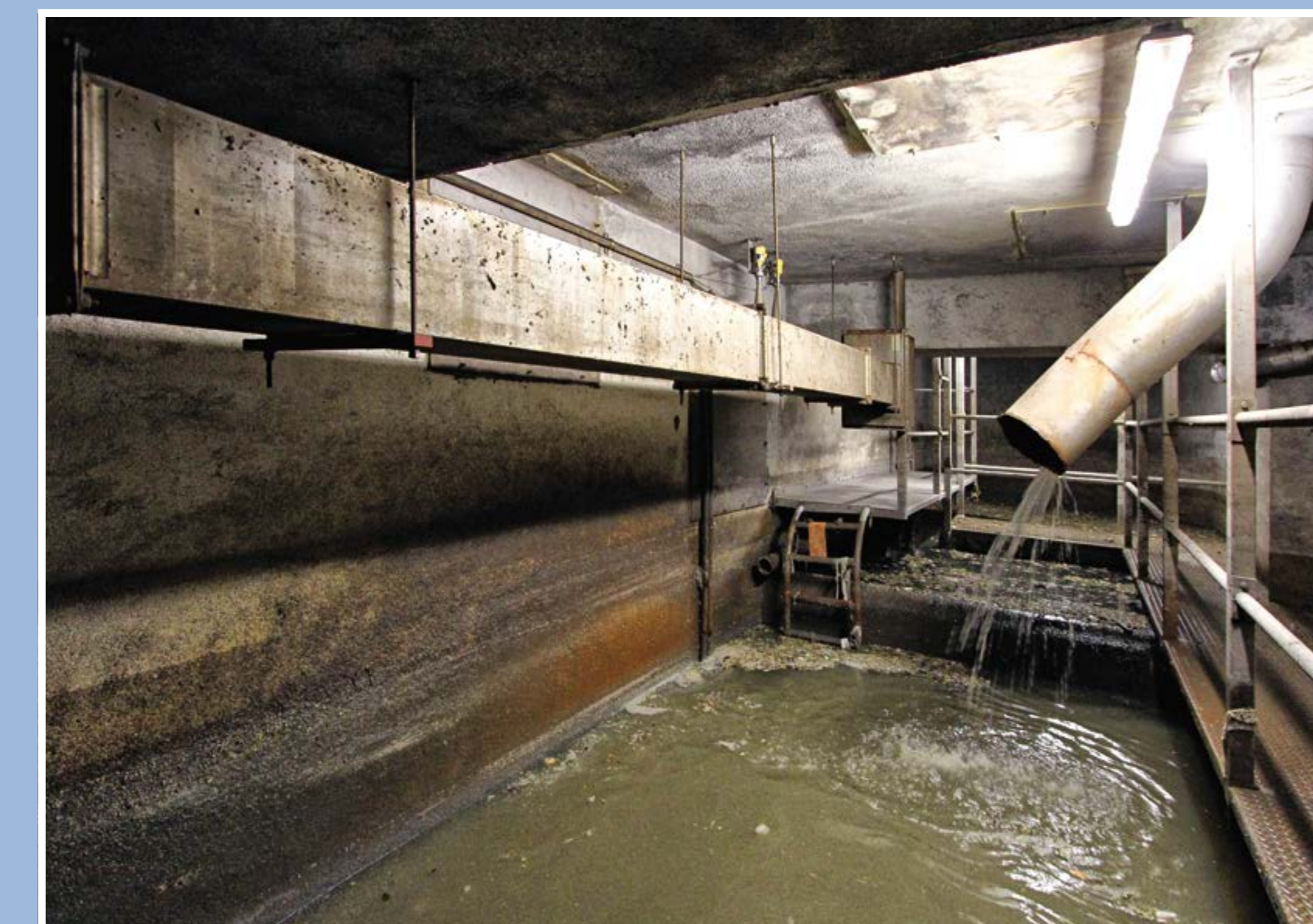
Trockenwettersumpf (vorne) und Regenwettersumpf (hinten)
