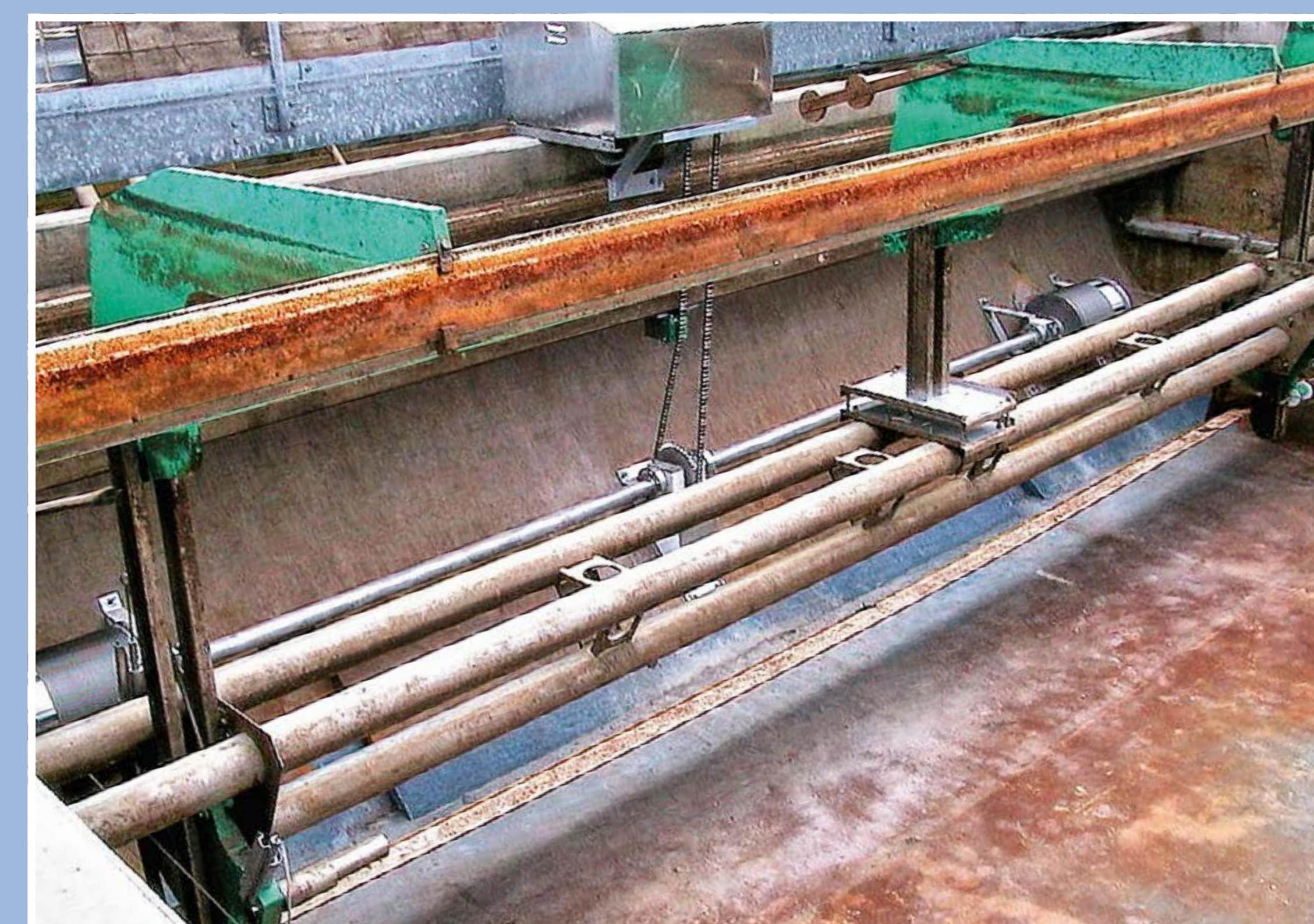
Räumler bei geleertem Becken
