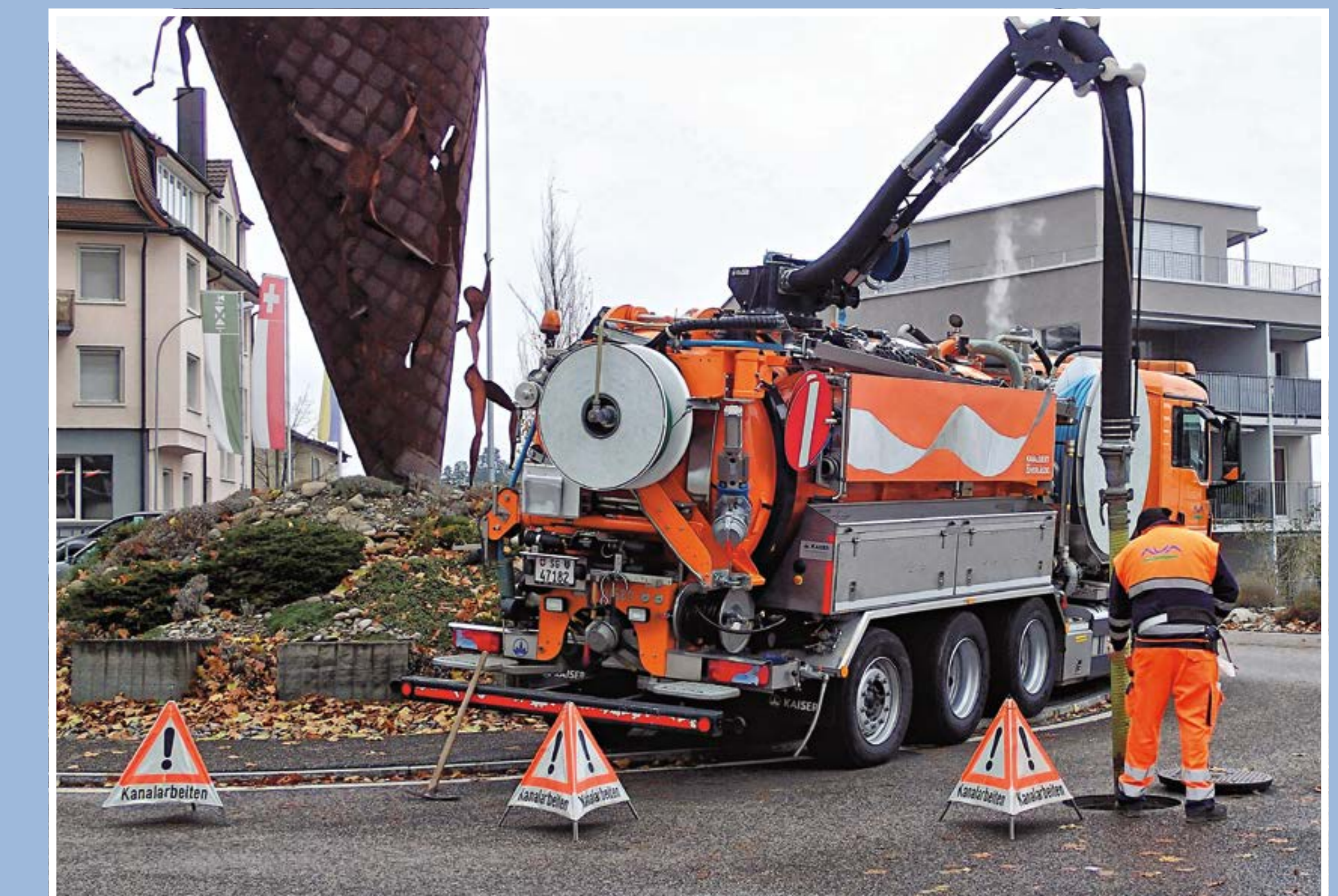
Kanalreinigungs-Equipe im Einsatz
