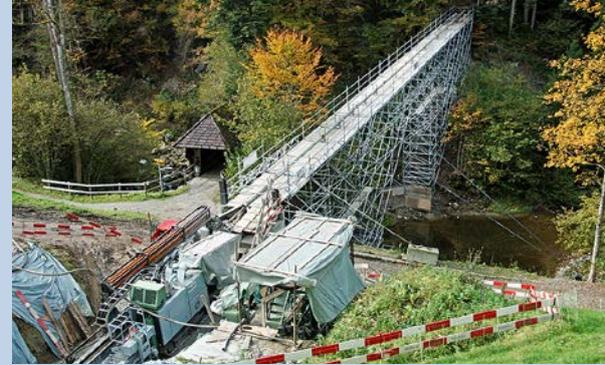
Horizontalpülbohrung über Goldacht: Gerüst für Rohrgestänge
