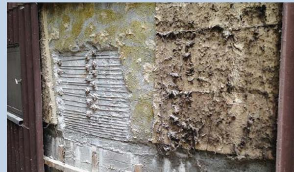
Zustandsuntersuchung der Stapel-Mischbehälter (v.a. freigelegte Vorspanndrähte)
