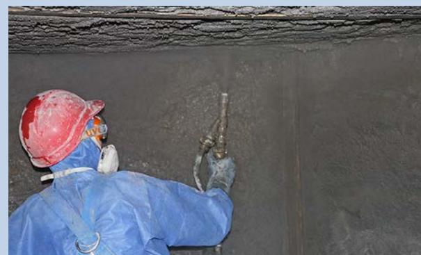
Betonsanierung Schacht AM2.0: Oberflächenbeschichtung
