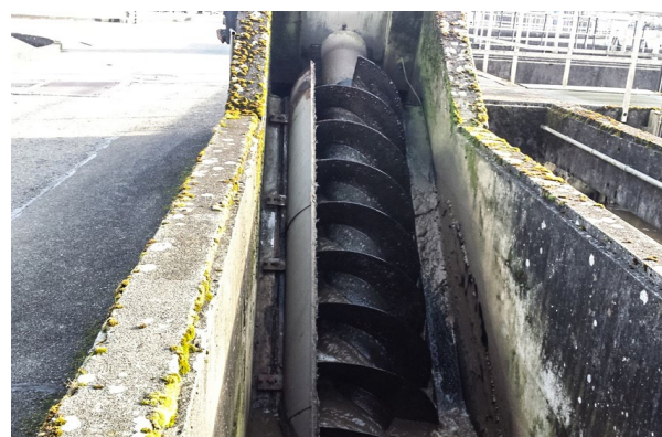
Alte Rücklaufschlammpumpe
