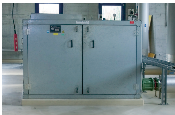
Einer der acht ersetzten Verdichter
