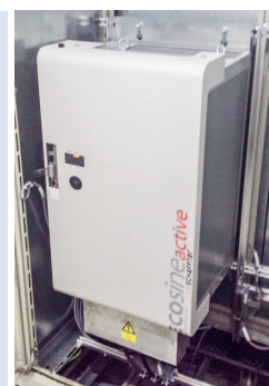
Aktiver Oberwellenfilter (Gebläse Belebtschlamm-biologie)
