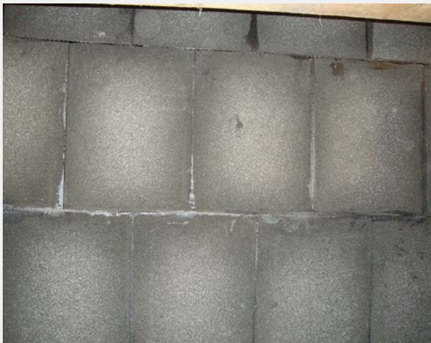
Fig. 6 Verklebte Schaumglasplatten Plaques de verre cellulaire collées
