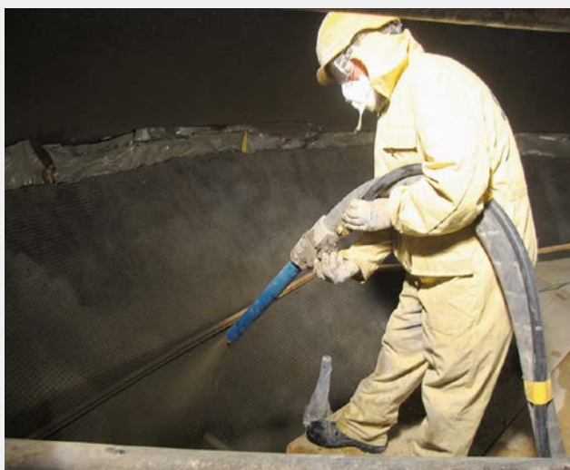
Fig. 10a und b Aufbringen der Spritzbetonschicht im Trichter Pose de la couche de béton projeté dans la trémie
