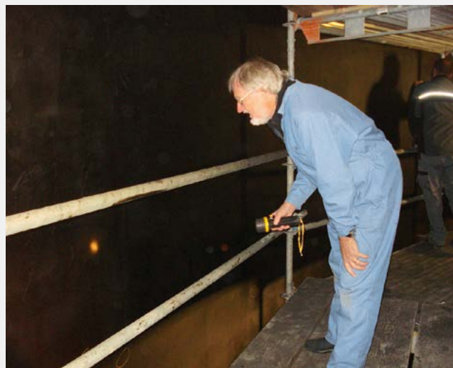
Fig. 11 Kontrolle der Beschichtungsarbeiten Contrôle des travaux de revêtement
