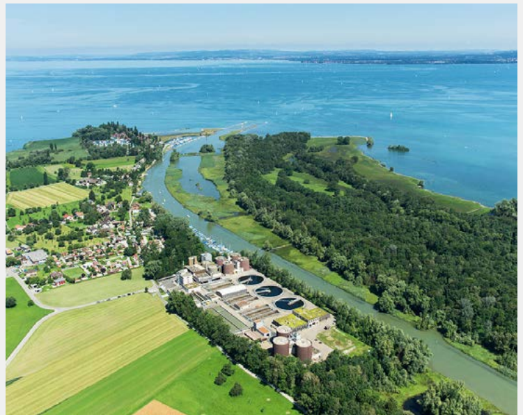
Fig. 1 Ansicht ARA Altenrhein, im Vordergrund die drei Faultürme (Foto: AVA) Vue de la STEP d'Altenrhein avec, au premier plan, les trois digesteurs
