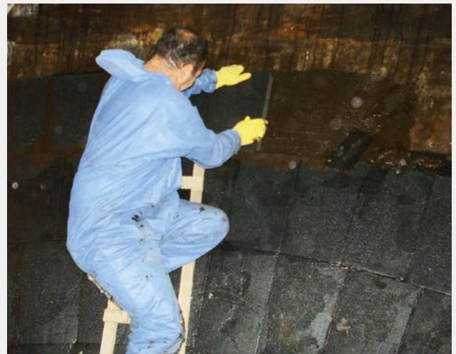
Fig. 9 Einbau der Schaumglasplatten im NFR-Trichter Pose des plaques de verre cellulaire dans la cuve du digesteur
