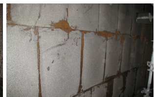
Montierte Foamglasplatten
