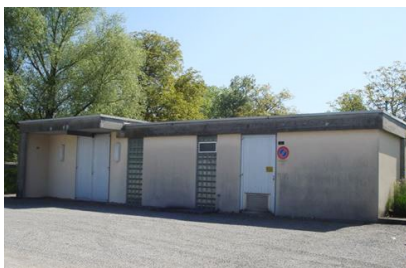
PW Steinlibach – Aussenansicht
