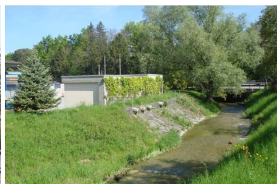
PW Steinlibach – Einleitstelle
