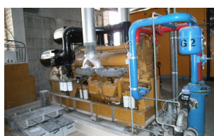
Notstromaggregat Jahrgang 1975
