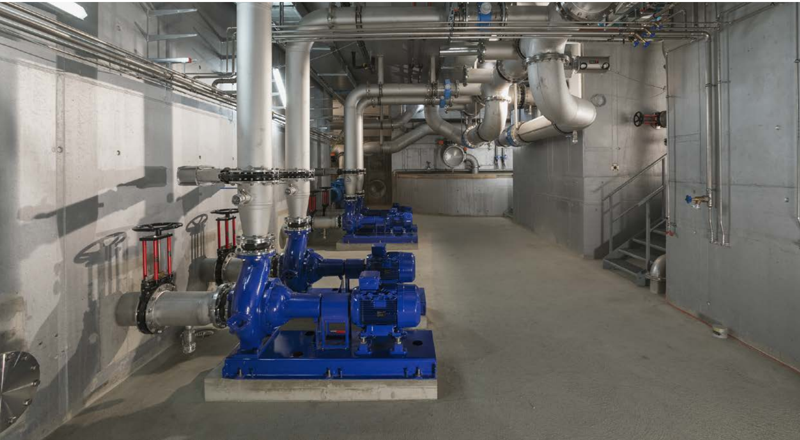
Einblick in das UG des neuen Gebäudes: Pumpensumpf (links), Pumpen (Mitte), Ozonreaktoren (rechts) und GAK Filter (hinten, unten)
