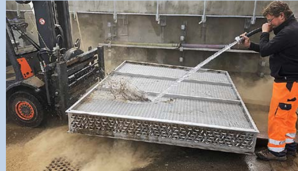
Reinigung Wärmetauscher
