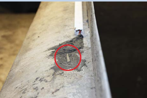
Temperatursonde am Klärüberlauf
