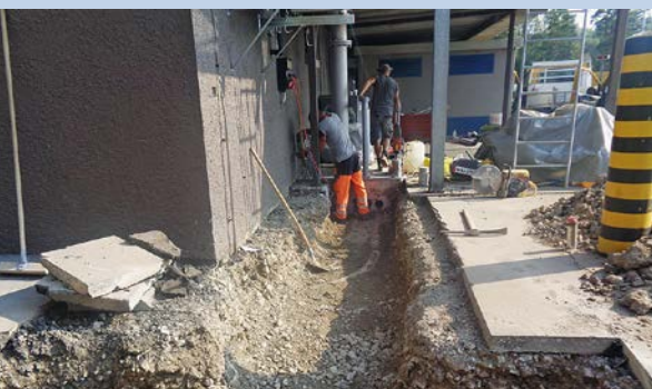
Grabenbau für Verbindungsleitung zwischen den Trafostationen TS1 und TS2
