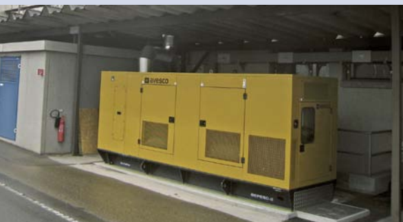
Notstrom-Aggregat: aussen-aufgestellt
