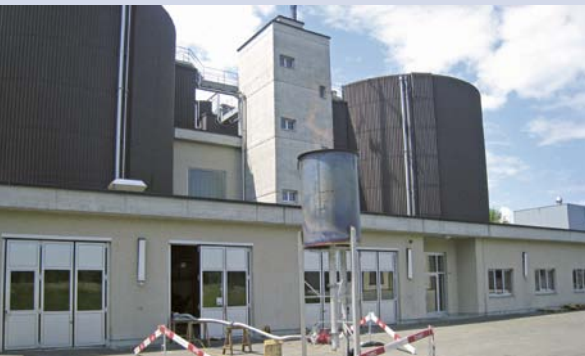
Klärgasvernichtung mit Gasfackel
