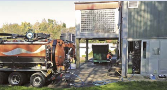
Ozonierungsversuche mit GAK auf der ARA Eriskirch mit gereinigtem Abwasser des AVA
