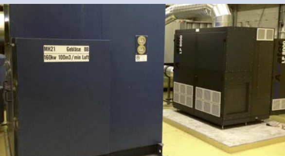
links: altes Drehkolbengebläse; rechts: Turboverdichter
