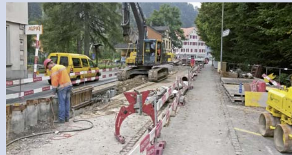
Kanalumlegung Rheineckerstrasse – Thal
