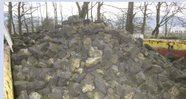
Durch den Hitzeeinfluss zerstörtes Isolationsmaterial (Foamglas)
