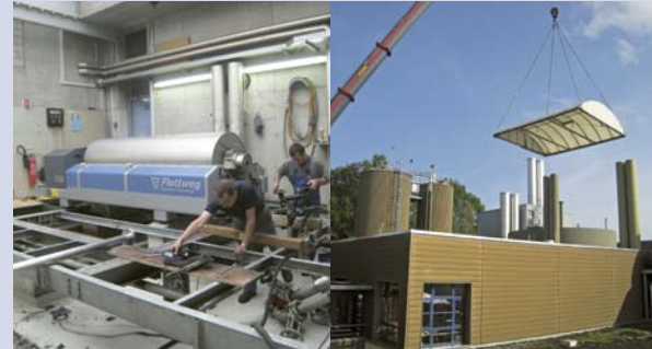
Installation über Dachöffnung am gleichen Ort wie das Vorgänger-Aggregat
