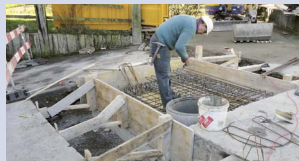
Neubau Kiesfang Düker Freibach
